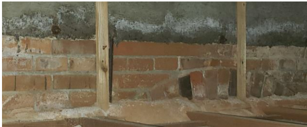
【レンガ積みされた旧官舎の壁構造】
