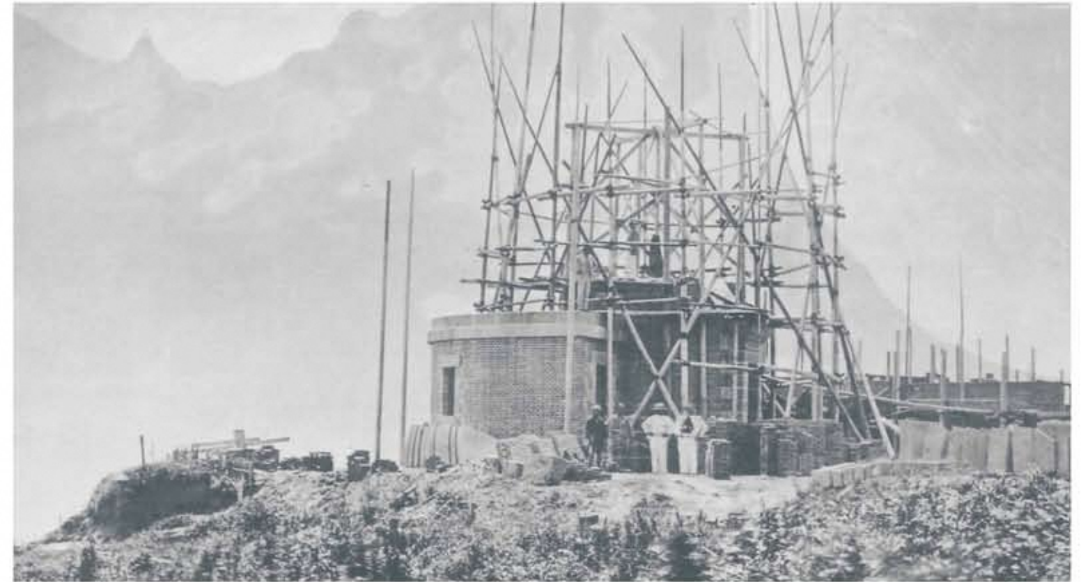
建設中の御前崎灯台、真ん中の白い服の男性がブラントンと思われる
